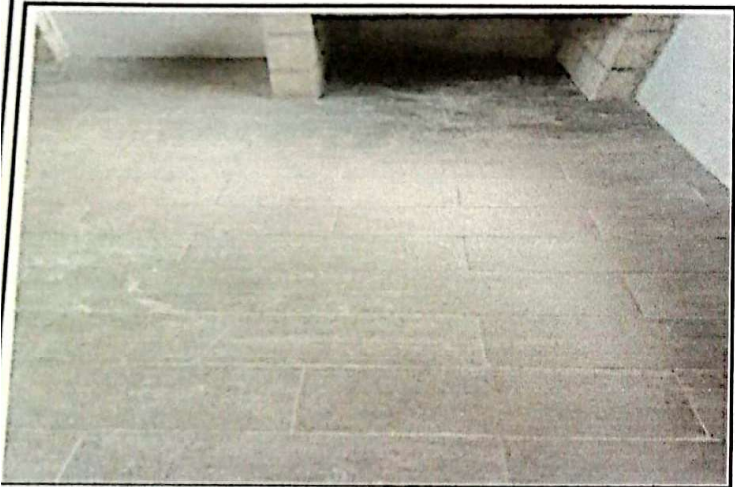
Foto 3: Reparación o sustitución de área de cocina
