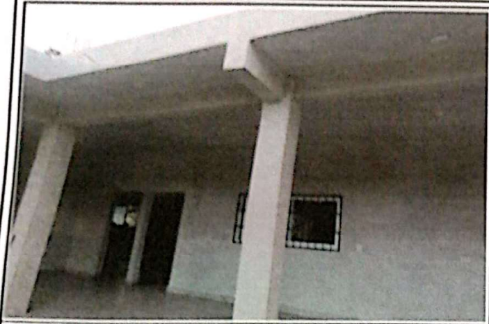
Foto 1: Reparación de sistema eléctrico
