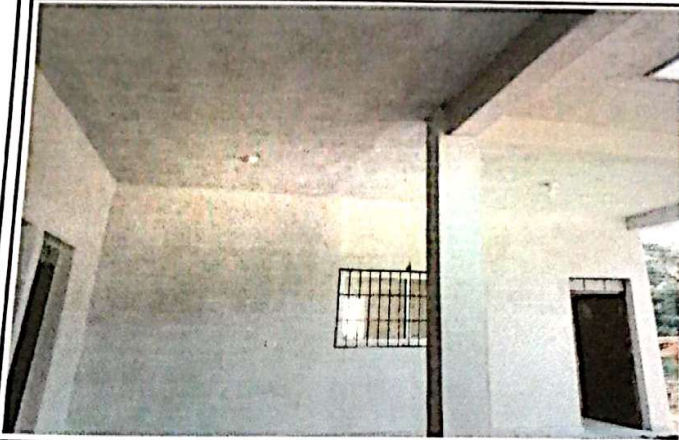
Foto 1: Reparación de repello y cernido de paredes
