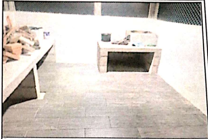
Foto 2: Reparación o sustitución de área de cocina
